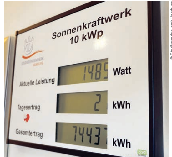
Wohnanlage Hammerbrook: Eine Anzeigetafel lässt die Bewohner:innen visuell an der Leistung und dem Tagesertrag des Sonnenkraftwerks teilhaben.
