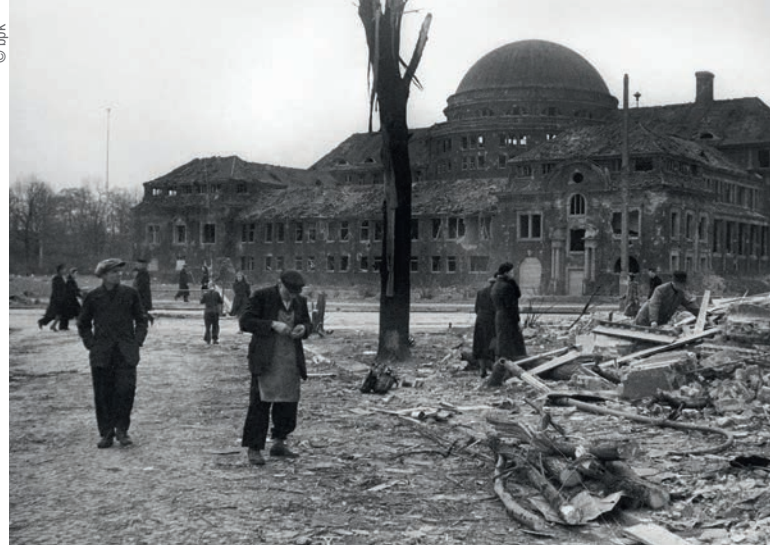
Das durch Bombenangriffe schwer beschädigte Gebäude der Universität Hamburg, 1945.
